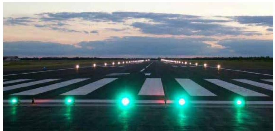
La iluminación a instalar consistirá en balizas empotradas con luces de color verde para ambos sentidos de circulación. Las fuentes de luz serán tipo LED, constituyendo una clara apuesta por la protección ambiental (producen menos emisiones de CO<sub>2</sub>, así como menor contaminación lumínica) y ahorro energético (menor consumo -65% menos-, elevada durabilidad).
